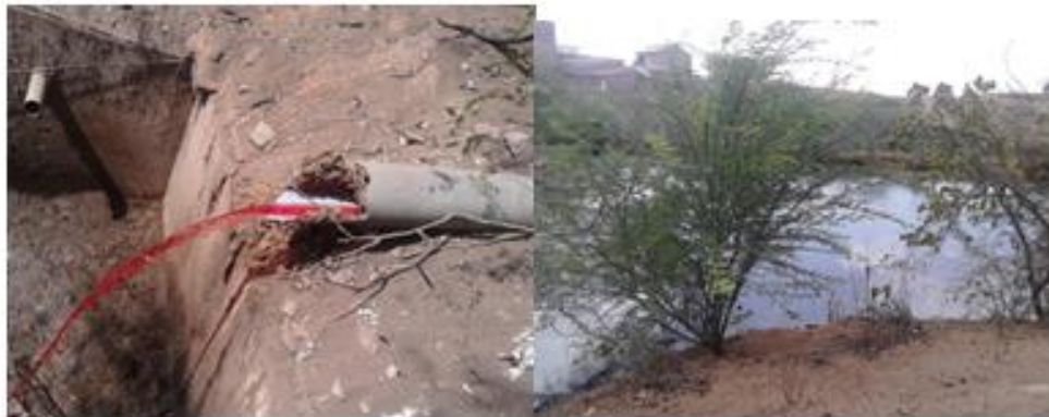
FIGURAS: (4) Esgoto inadequado e (5) destino final dos resíduos do abate no abatedouro público de Jaguaribe, Ceará, Brasil.
