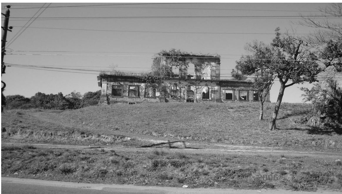
Figura 1 – Ruínas da Fazenda São Bernardino. Construção imponente do período da Vila de Iguassú, este relevante patrimônio histórico do município encontra-se abandonado e sendo alvo de destruição (Autor: Everaldo Lisboa, Julho de 2008).
