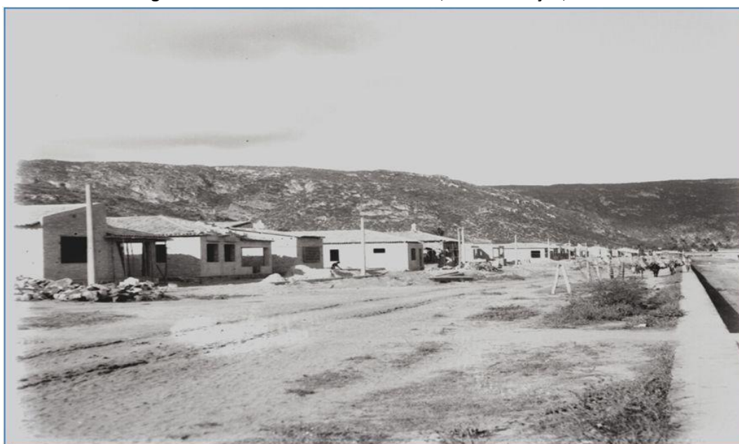
Figura 3- Avenida Orlando Oliveira Pires, em construção, em 1956
