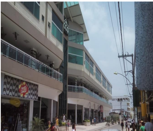
Figura 4. Fachada do Centro comercial e calçadão após “requalificação”
