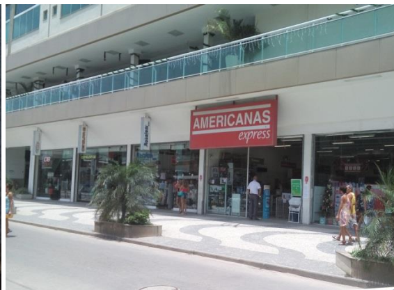
Figura 5. Fachada do Centro comercial e calçadão após “requalificação”
